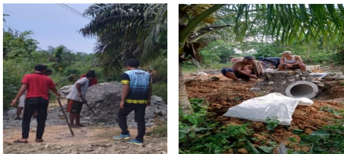
Gambar. 3 Proses perbaikan jalan desa dan pembuatan drainase di RT 10
